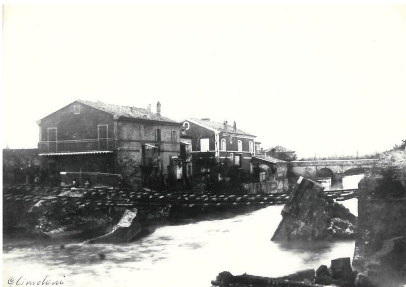
**Fig. 97. Ponte ferroviario crollato alla foce del cavo Penna**
