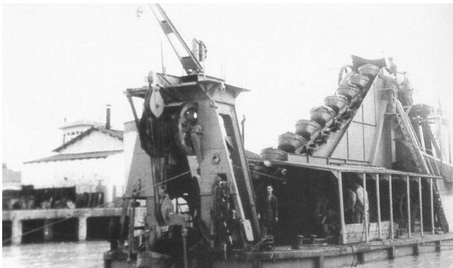
**Fig. 23. Draga al lavoro di escavazione dei fanghi nel porto**
