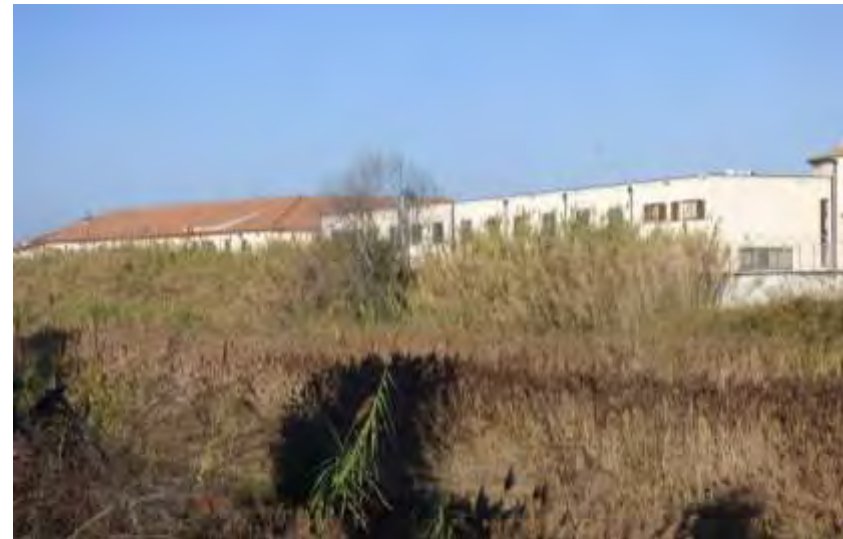
Fig. 186 - 2019 esterno della caserma da oltrefiume
