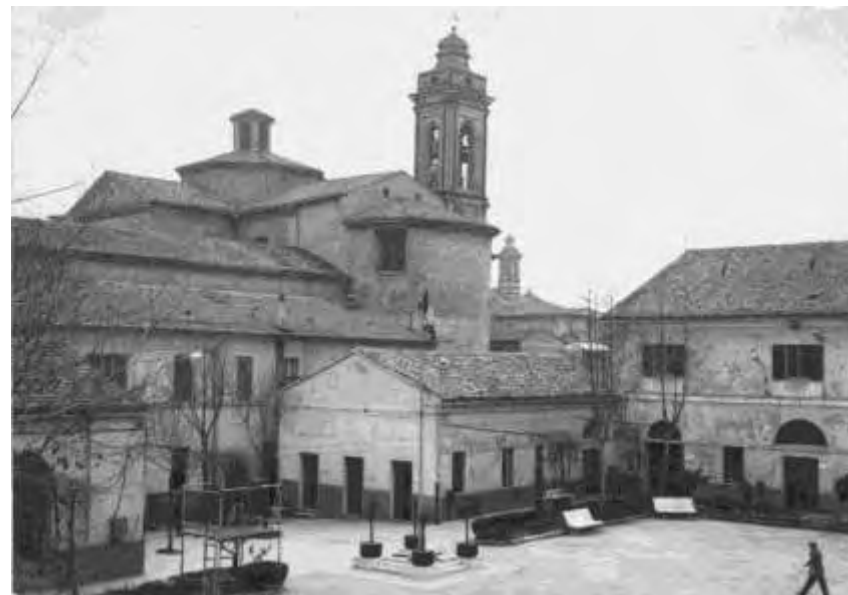
Fig. 146 - Cortile di ingresso caserma prima dei lavori di ristrutturazione degli anni 1980
