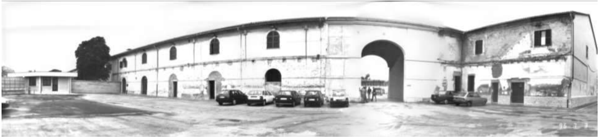
Fig. 164 - Lavori di ristrutturazione: panoramica del 3 luglio 1996 (rielaborazione degli autori)
