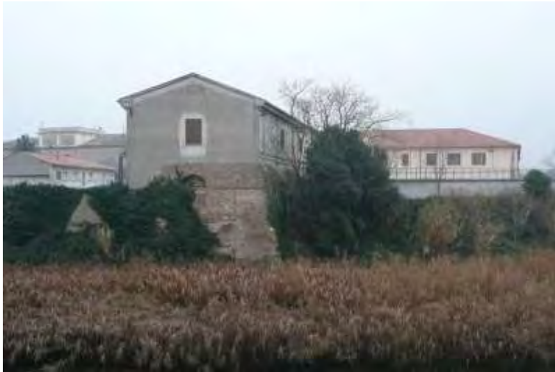
Fig. 183 - 2019 esterno della caserma da oltrefiume
