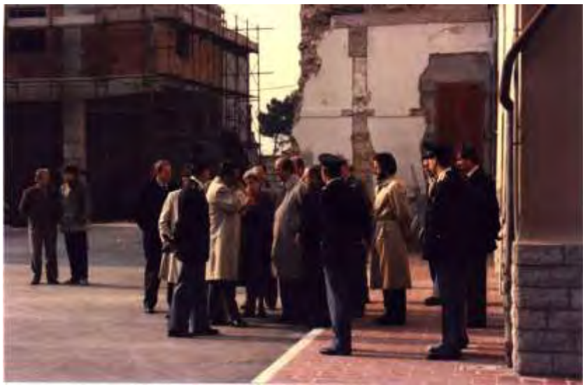
Fig. 160 - 1984: squarcio aperto nelle mura urbane con la nuova palazzina extra moenia ancora in costruzione sullo sfondo
