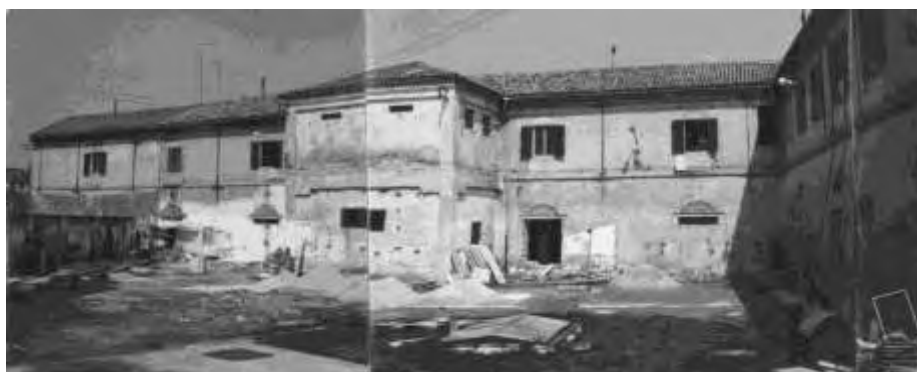
Fig. 145 - 1969 lavori di ristrutturazione Caserma Avogadro di Casanova
