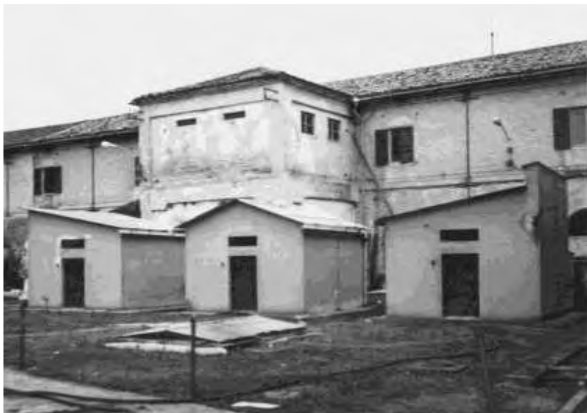
Fig. 144 - 1969 lavori di ristrutturazione Caserma Avogadro di Casanova
