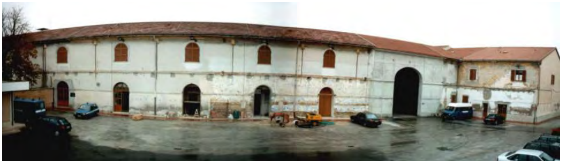
Fig. 165 - Altra panoramica del 1996 con i lavori in corso
