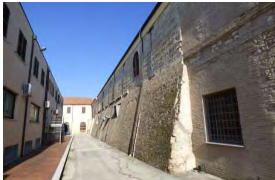
Fig. 171 - 2019 corridoio tra le mura urbiche e la "nuova palazzina"
