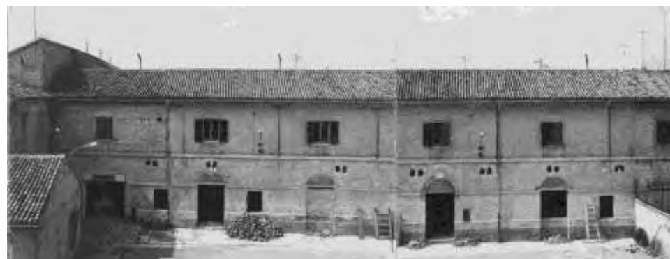
Fig. 147 - 1969 lavori di ristrutturazione Caserma Avogadro di Casanova
