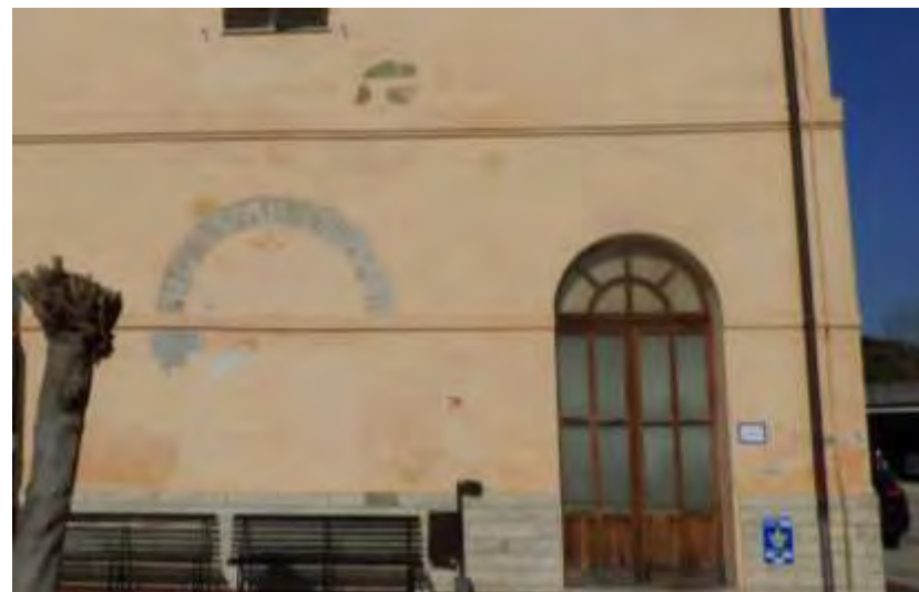
Fig. 180 - 2019 particolare: mattoni a vista traccia delle vecchie aperture
