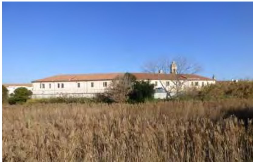
Fig. 184 - 2019 esterno della caserma da oltrefiume
