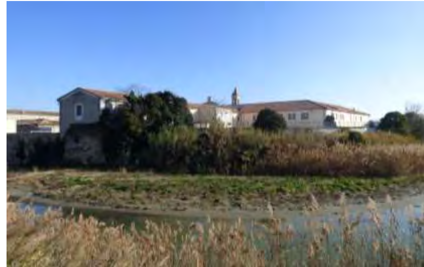
Fig. 185 - 2019 esterno della caserma da oltrefiume
