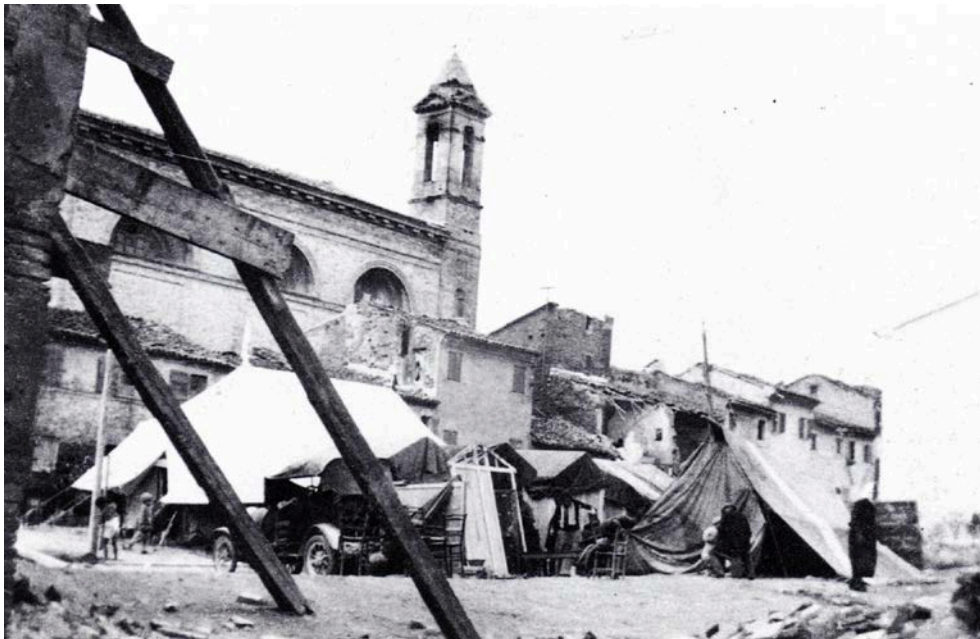
25. Senigallia, tende e baracche in via Smirne nel rione Porto dopo il terremoto del 1930. In alto la chiesa parrocchiale di Santa Maria del Ponte (foto già edita in Cecilian-Negri, Il terremoto del '30 , cit., p. 61, e in Pegoli G., Senigallia. I luoghi della gente , cit., p. 238.)
