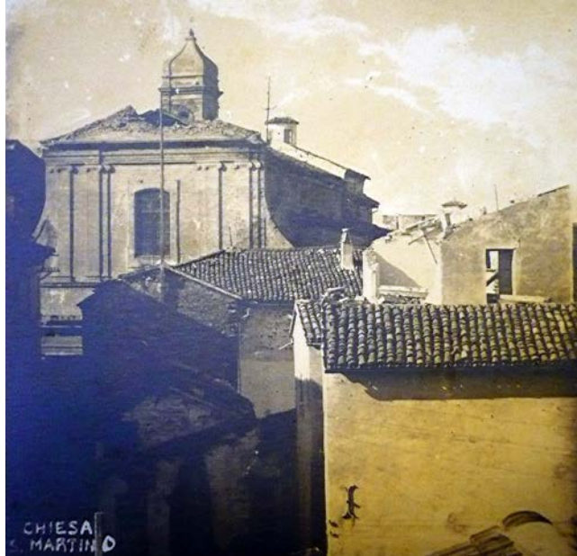
4. Il tetto crollato della chiesa di S. Martino (ASCS, album 11, foto n. 827)
