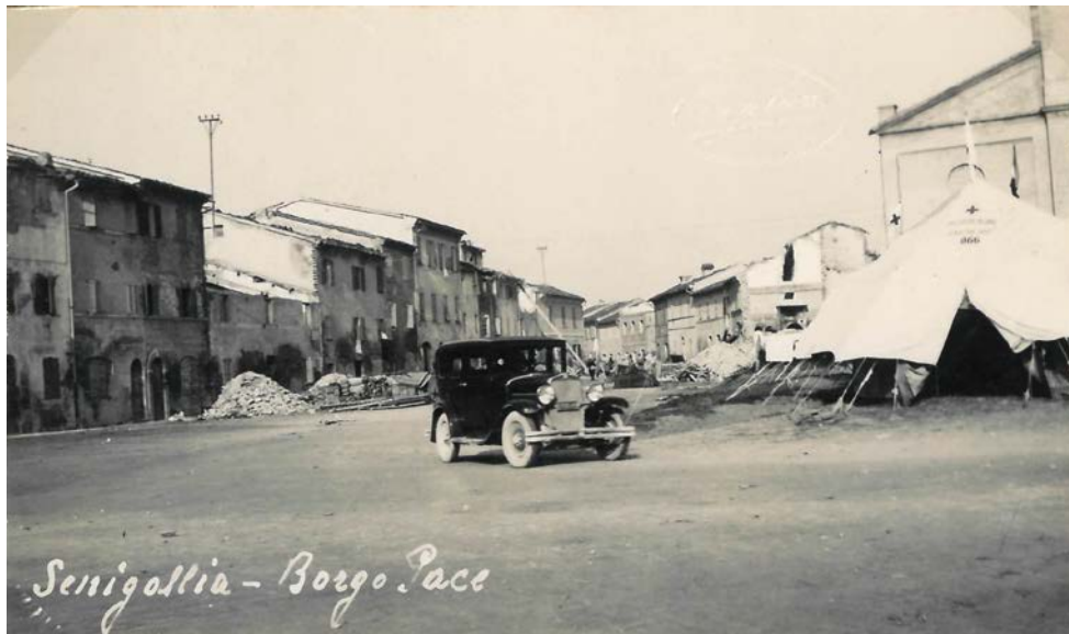
6. Senigallia, terremoto 1930: tendone della Croce Rossa innalzato davanti alla parrocchia della Pace (in Largo Verdi, poi Largo Boito), in seguito abbattuta per i gravi danni subiti (ASCS, Album fotografico n. 13, n. 1022, foto Cingolani, Senigallia).
