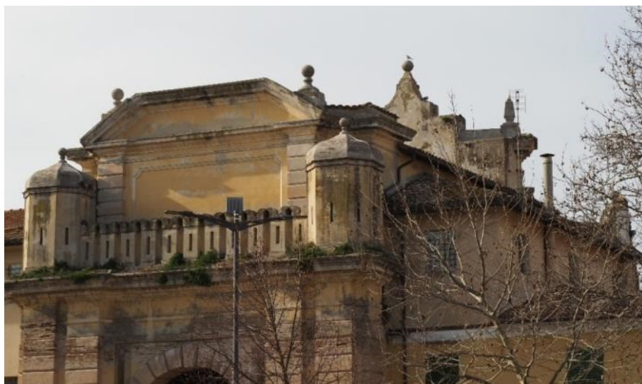
Fig. 19 - Il timpano della facciata su viale Leopardi nasconde la vista degli appartamenti dell'Opera Pia
