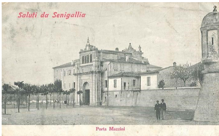
Fig. 39 - Casa Franceschetti-Mercuri addossata a Porta Mazzini, inizi '900 (foto g.c. da Gianluca Quaglia)
