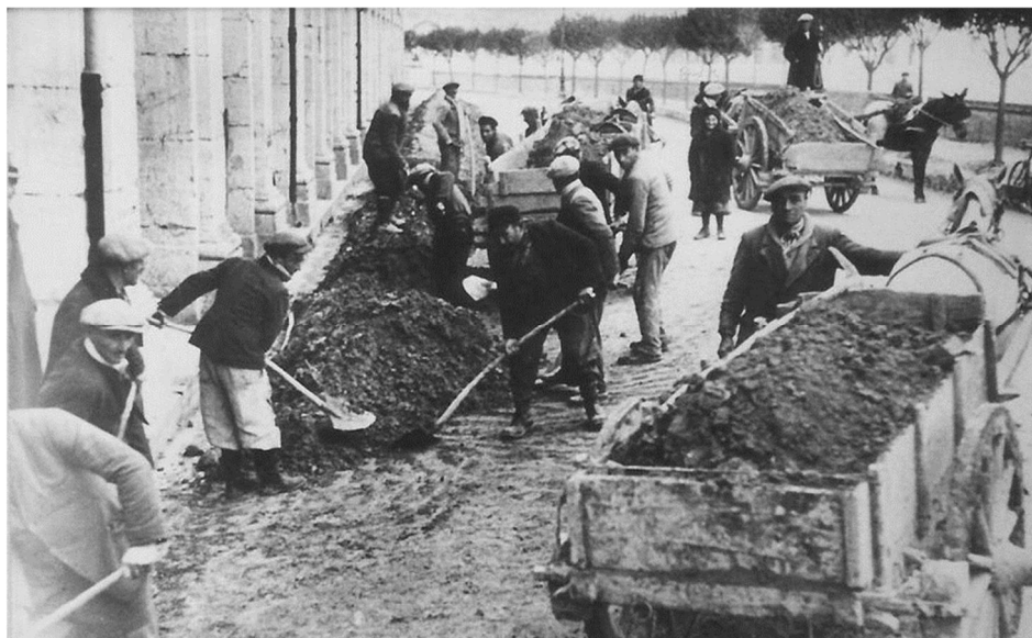
Fig. 29. Rimozione del fango in via Portici Ercolani
