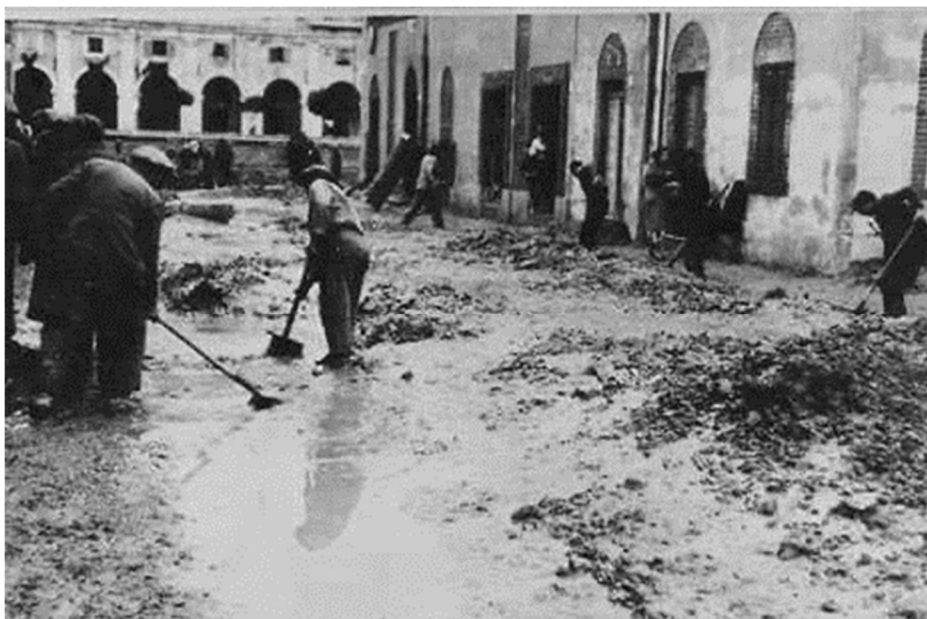
Fig. 28. Rione Porto: rimozione del fango in via Smirne
