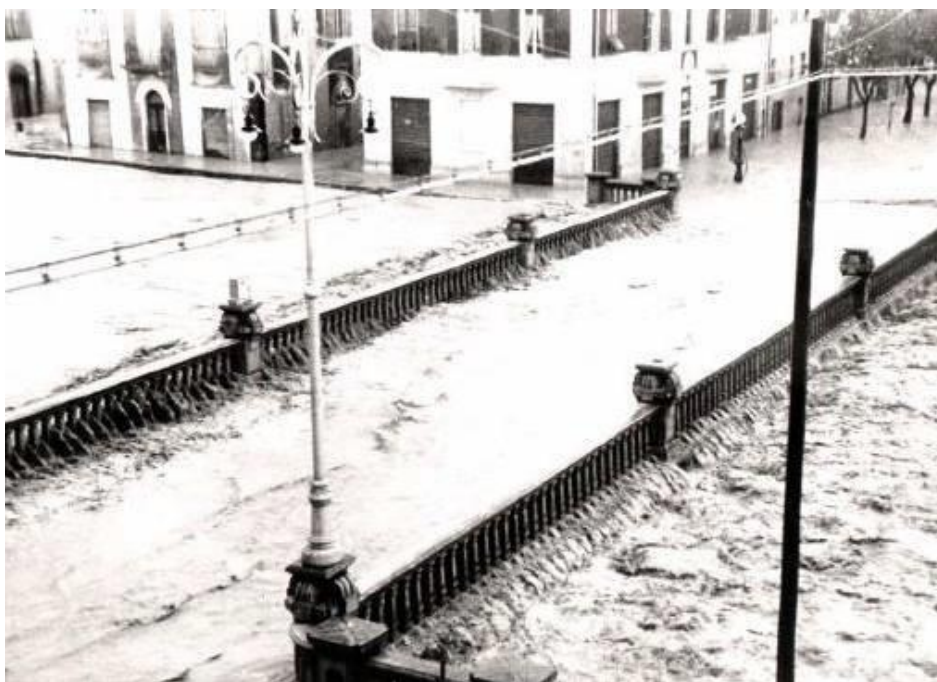
Fig. 22. Ponte XIII Settembre: l'acqua scavalca i pilastri della spalletta
