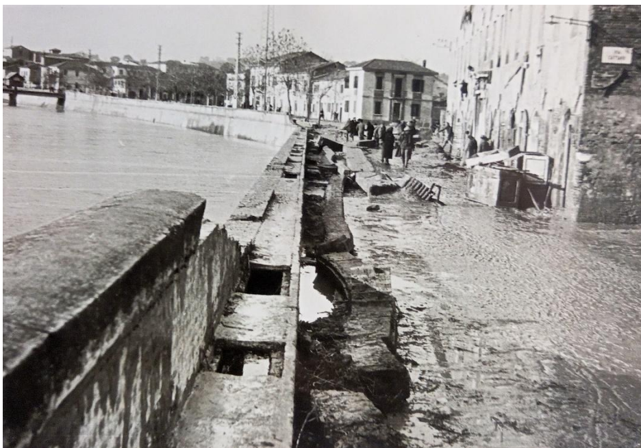
Fig. 26. Argine demolito in Via XX Settembre, all'incrocio con via Cattaro
