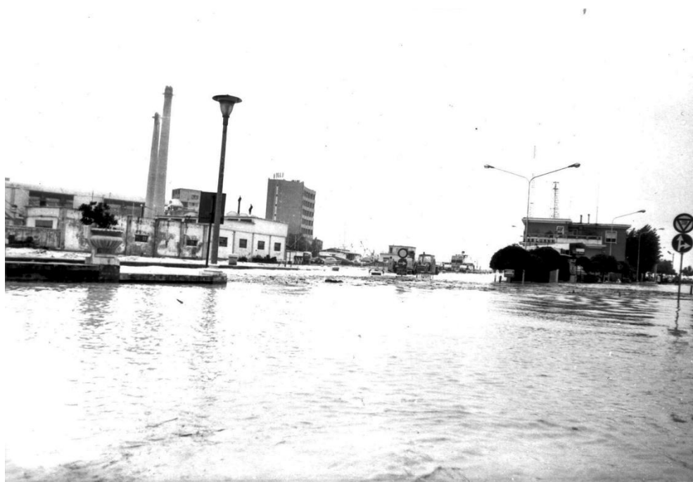
Fig. 75. Sottopasso via Perilli - via Bovio e banchina del molo di levante
