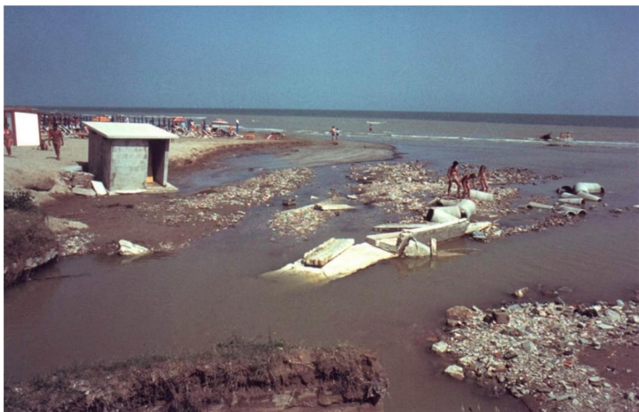
Fig. 81. Ponte Portelle all'incrocio del lungomare D. Alighieri con via Grosseto. La canalizzazione del fosso in mare è distrutta. Le due foto sono state archiviate senza l'indicazione della località, che è stata attribuita dagli autori di questa ricerca.
