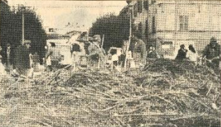
Personale del Comune ripulisce il ponte 2 Giugno
