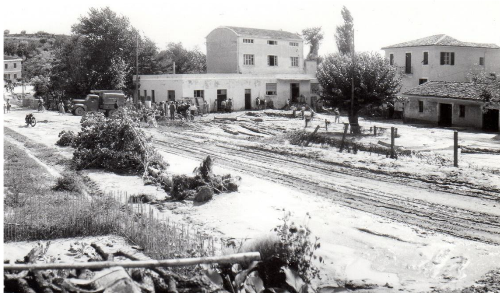
Fig. 42. Bassa di Ripe: molino di Lamberto Olivi invaso da acqua e fango L'edificio alto al centro è un moderno molino a cilindri; la casupola bassa a destra era un molino tradizionale a macine in pietra, dapprima idraulico poi elettrificato.
