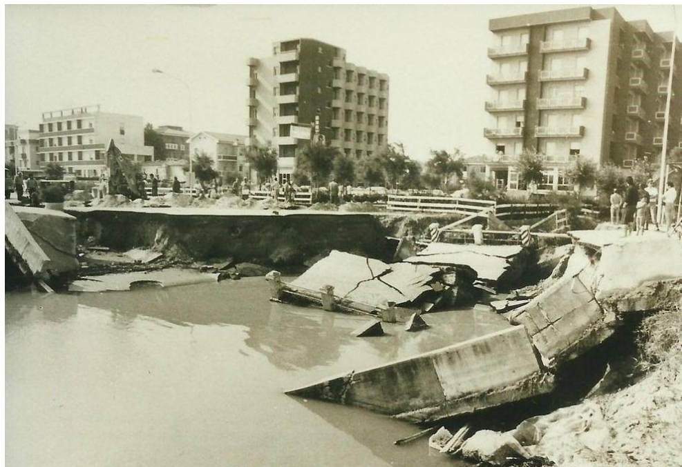
Fig. 78. Ponte crollato sul lungomare L. Da Vinci, zona ristorante da Peppino presso hotel Metropol (al centro) per l'esondazione del fosso dell'Alderana (Leopoldi)
