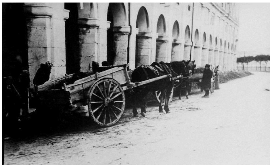
Fig. 30. Rimozione del fango sotto i Portici Ercolani
