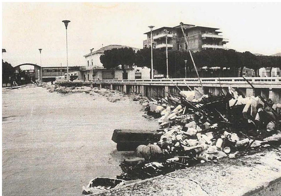
Fig. 70. Ponte Garibaldi e arco del Consorzio Agrario (Foto Leopoldi) Notare la grande quantità di detriti e rifiuti trasportati dal fiume.
