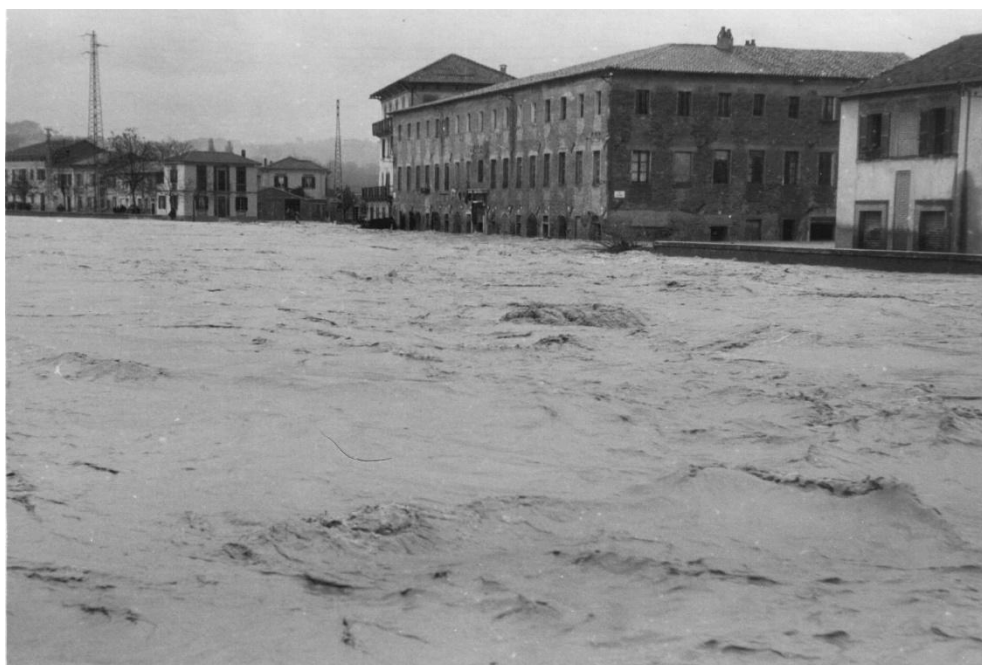
Fig. 16. La piena ha demolito il parapetto di via XX Settembre Il grande palazzo che si vede è il fondaco del Collegio Germanico-Ungarico
