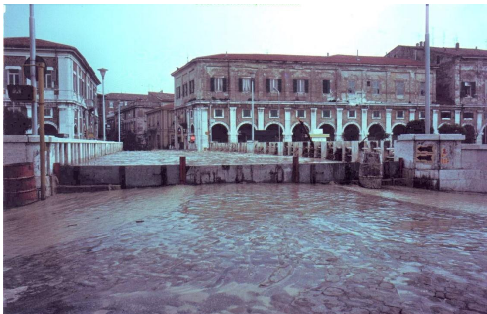
Fig. 68. 19 agosto 1976, il Misa deborda dalla paratia mobile del Ponte 2 giugno Il Misa fuoriesce dalle paratie mobili del Ponte 2 Giugno; a sinistra via Dogana Vecchia; a destra via XX Settembre; al centro via Carducci allagata. Si noti la mancanza della mensola asportata dall'acqua sopra i pilastri del parapetto a destra del ponte.
