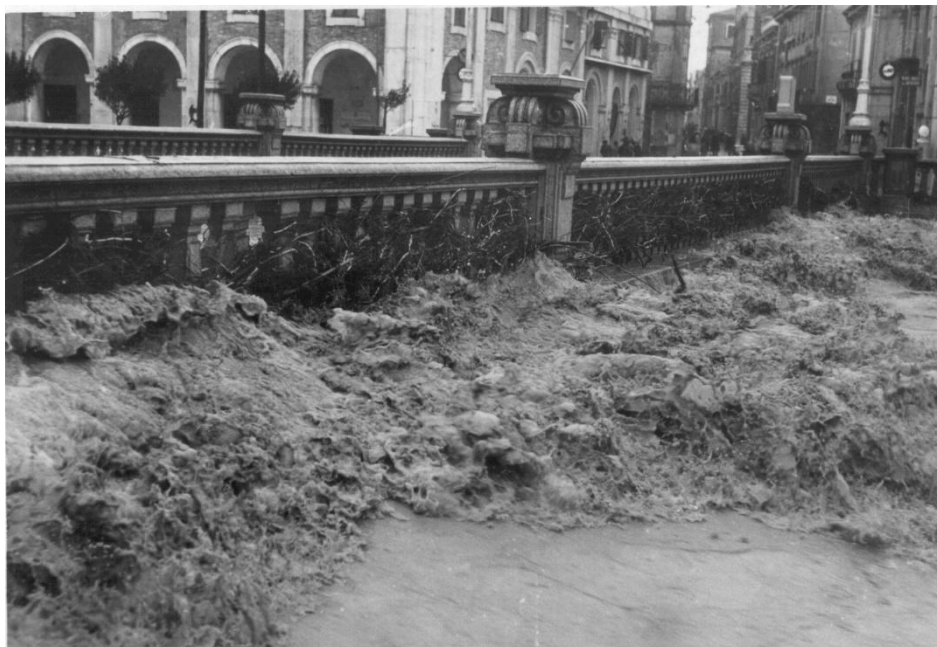
Fig. 21. Detriti ammassati alla spalletta del Ponte XIII Settembre (o del Corso)
