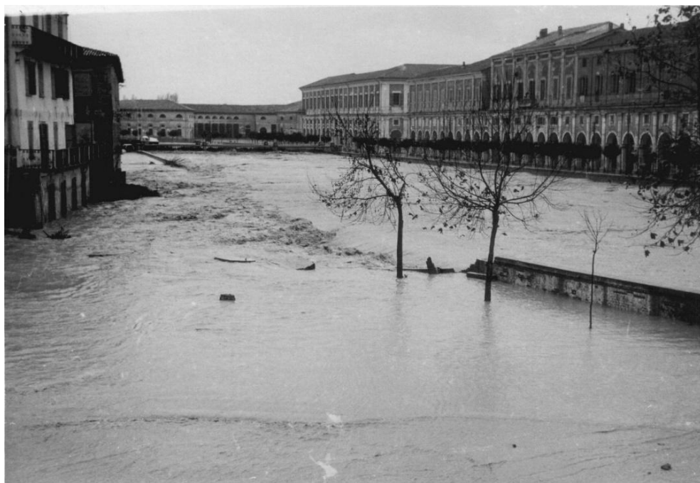
Fig. 12. 1940, argine del Misa demolito dalla piena in via XX Settembre
