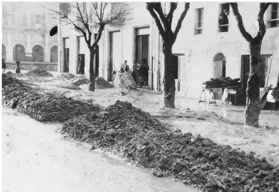
Fig. 27. Rimozione del fango in via Carducci
