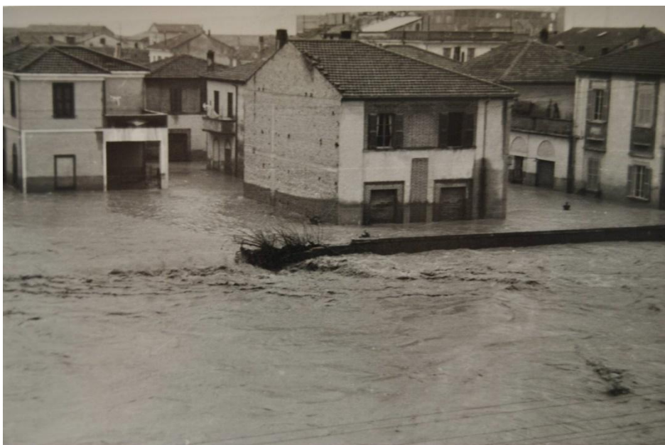
Fig. 18. Case del quartiere Porto allagate per la rottura dell'argine È ben visibile la linea scura dove era arrivata l'acqua prima di ritirarsi.
